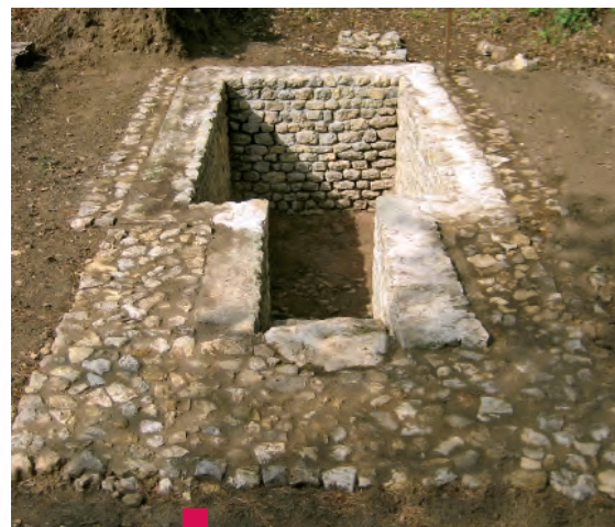
Bassin après restauration
